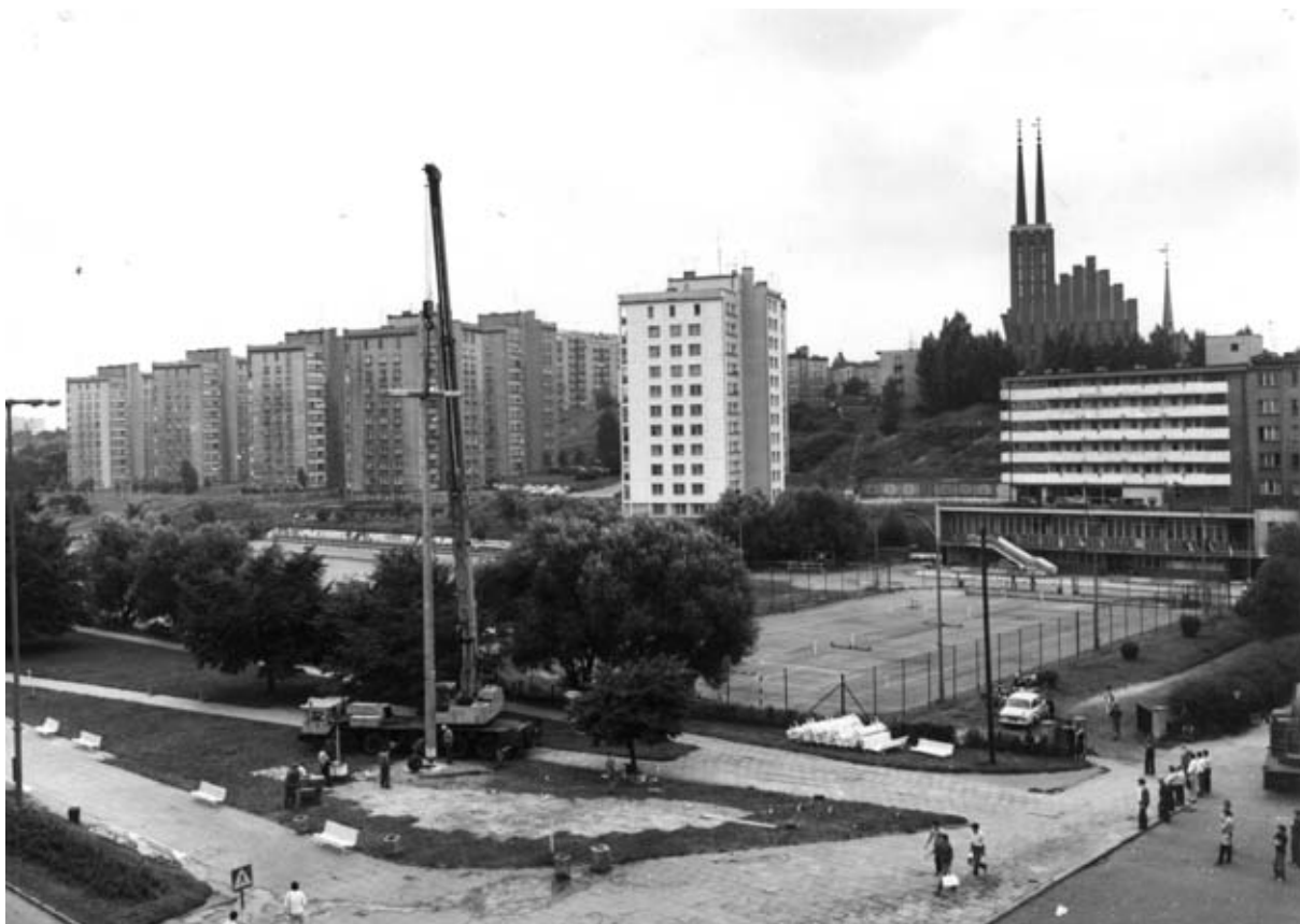
Stawianie krzyża w miejscu przyszłego pomnika.
