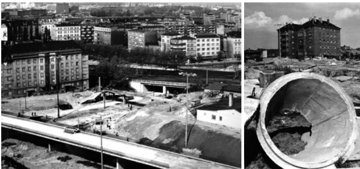
Budowa Wiaduktu Pokoju, rok 1974. Zbiory APGoG.
