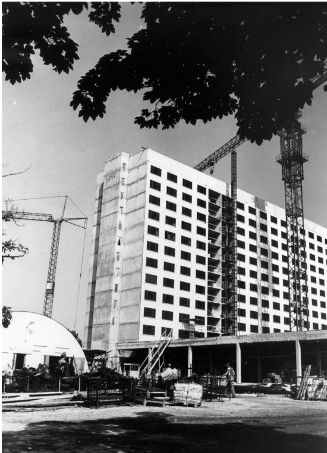
Budowa Hotelu Gdynia. Zbiory MMG.
