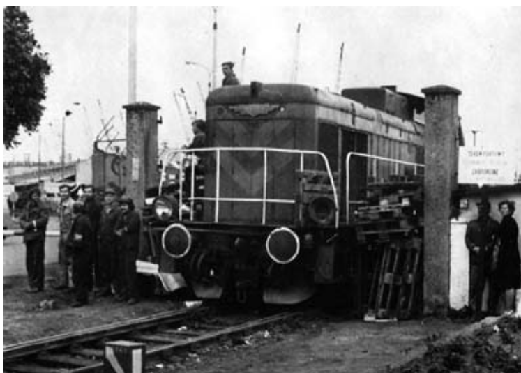
Lokomotywa blokująca bramę do portu.
