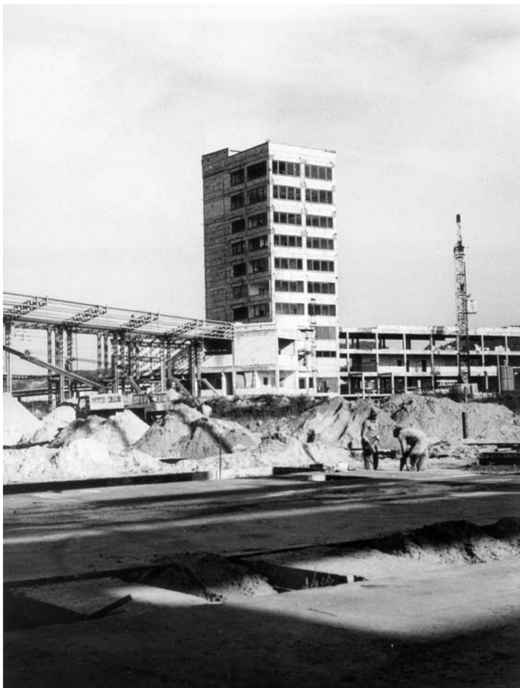
Budowa bazy kontenerowej w Gdyni. Zbiory IPN Gdańsk
