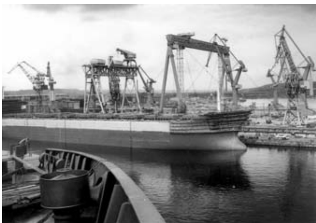
Stocznia – stawianie suwnicy.
