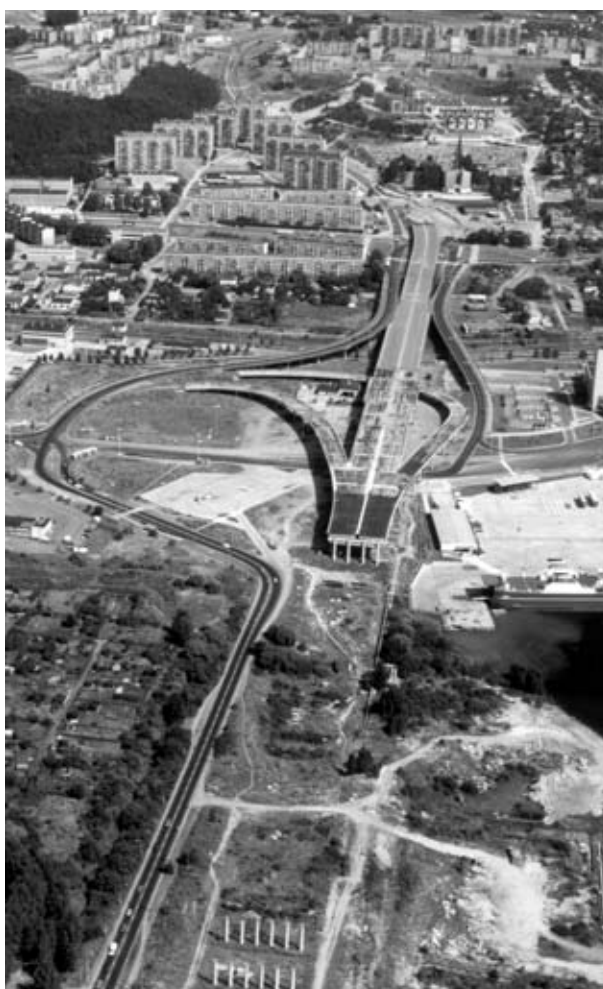
Niedokończona budowa estakady. Zbiory Urzędu Miasta Gdyni.
